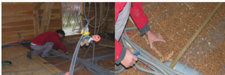
Isolation de plancher avec du liège
